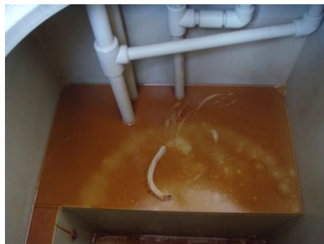
Фото 6, 7. Осад заліза, мангану та іонів важких металів, який випав з водопровідної води після обробки її озоном.
