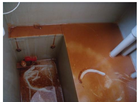
Фото 6, 7. Осад заліза, мангану та іонів важких металів, який випав з водопровідної води після обробки її озоном.
